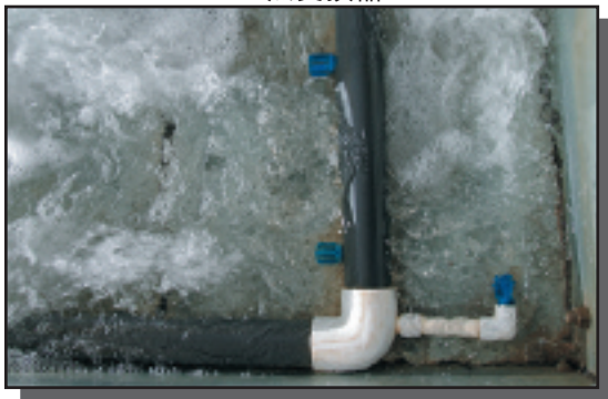
HydroBoosters喷嘴在搅动水流
